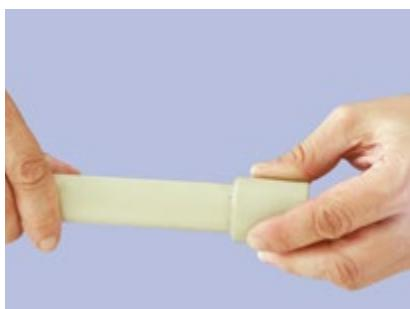
10 След изтичане на времето за нагряване, изваждаме фитинга и тръбата от накрайника и ги спояваме като вкарваме тръбата във фитинга до определената дължина с лек, бавен и равномерен натиск, без завъртане.
