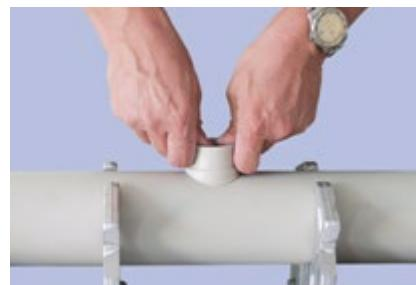
④ Нагрятото отклонение се поставя в отвора и спойката се фиксира за около 16 секунди. След 1 час може да се пълни с вода и да се натоварва под налягане.
