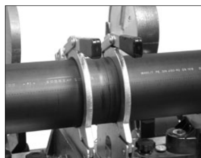
Трубы, правильно подготовленные к сварке
